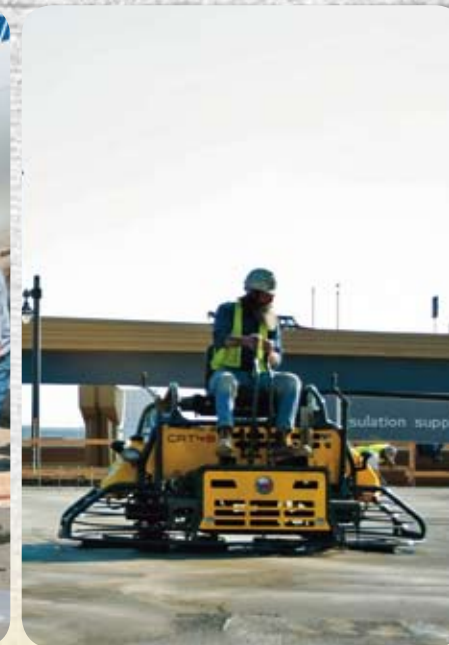
Trin 8: Glittemaskinerne anvendes til en fin og plan overflade: Først planering, derefter efterglitning og til sidste polering.
