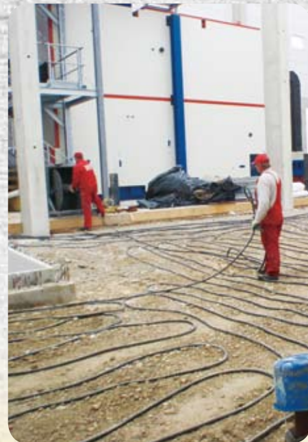
Trin 1: Afhængigt af temperaturen skal oplys og opvarmes før bearbejdning. E 700M fra Wacker Neuson er i den forbindelse den ideelle procesforstærker.
