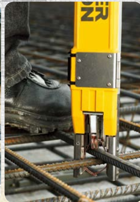
Trin 4: Armeringen indbygges og forarbejdes med armeringsbinder- og armeringsklipere fra Wacker Neuson.
