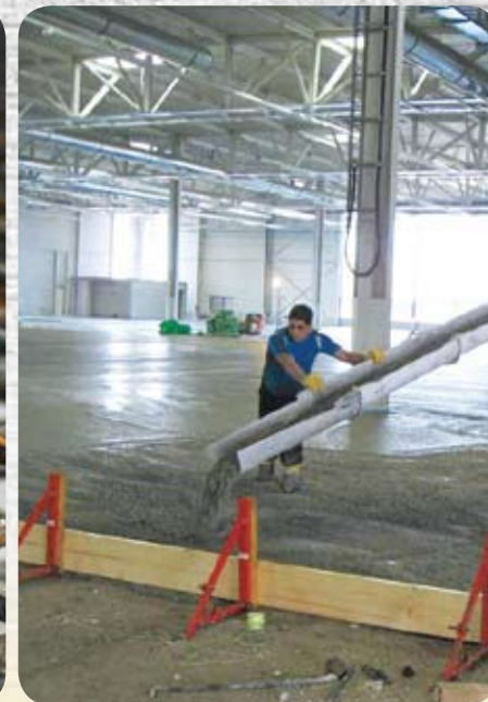
Trin 5: Den friske beton leveres og udlægges.
