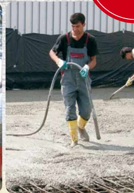
Trin 6: Efterfølgende skal betonen komprimeres. På den måde får den en førsteklasses kvalitet. Dertil egner det store sortiment af højfrekvens stavvibratører fra Wacker Neuson sig.
