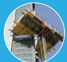
Arbeitsbühne an alle Wandformen anpassbar
